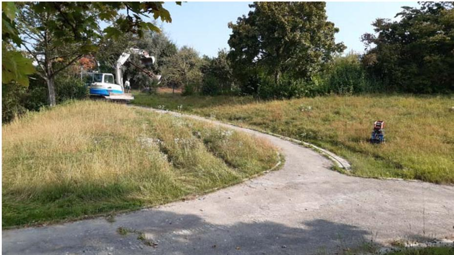
Die Aufschlussansatzpunkte wurden mit Maßbandgenauigkeit auf den Bestand **eingemessen**. Die Höhen ü.NN wurden durch **Nivellement** auf die Kanalschächte ZS 5.018 und M 8.018 ermittelt, deren Oberkanten im gemeindlichen Kanalplan mit 454,51 bzw. 459,46 m ü.NN angegeben sind. Die Hoch- und Rechtswerte wurden mit einer Genauigkeit von  $\pm 1$  m dem Liegenschaftskataster aus [3] entnommen.
