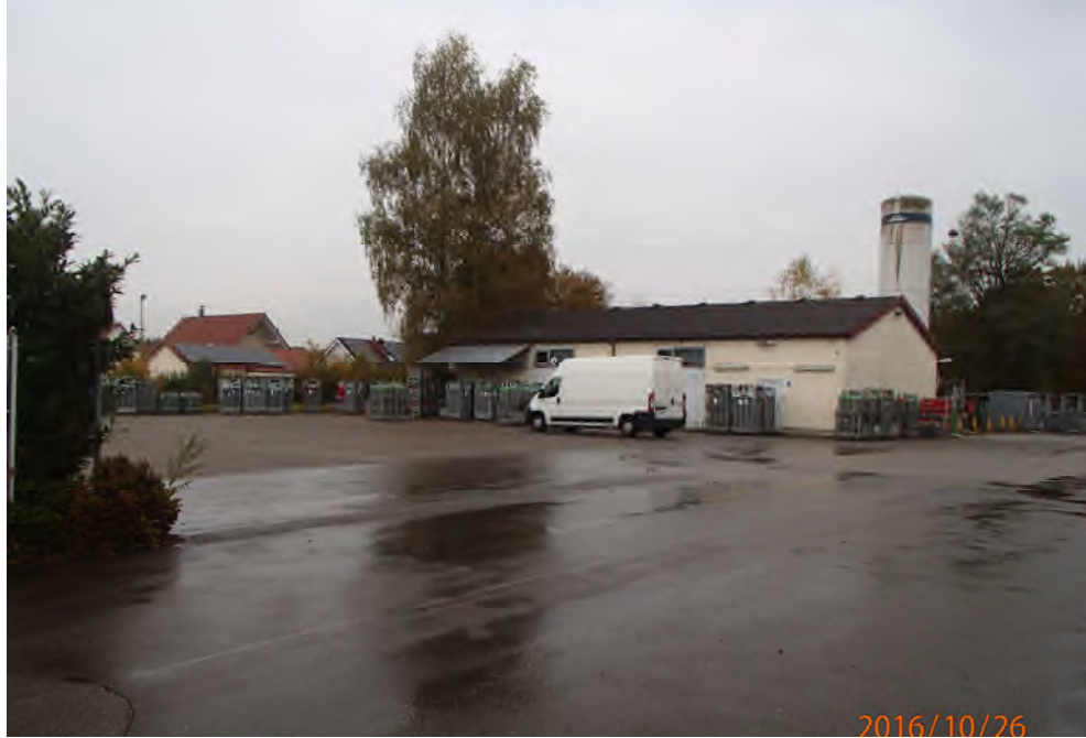
Foto 11: Ehem. Abfüllhalle Nordwest
