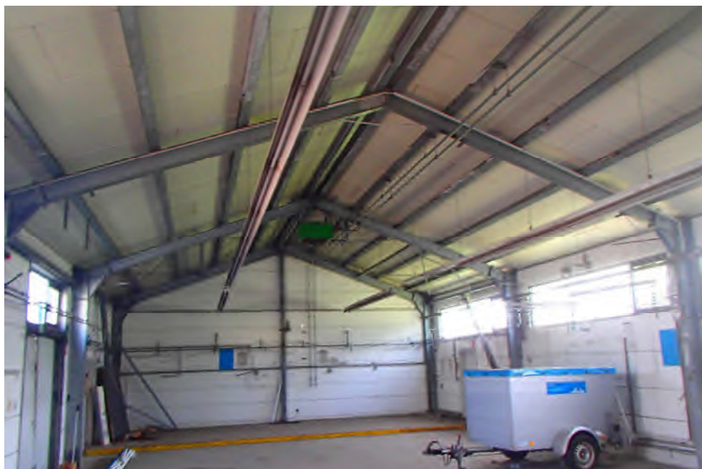
Foto 10: Ehem. Abfüllhalle Nordwest
