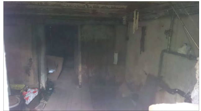
Abbildung 14: Kellerraum im Wohnhaus
