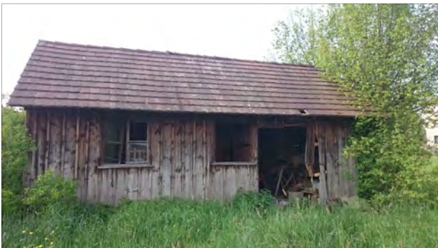
Abbildung 8: kleiner Schuppen im nördlichen Plangebiet durchgeführt.
